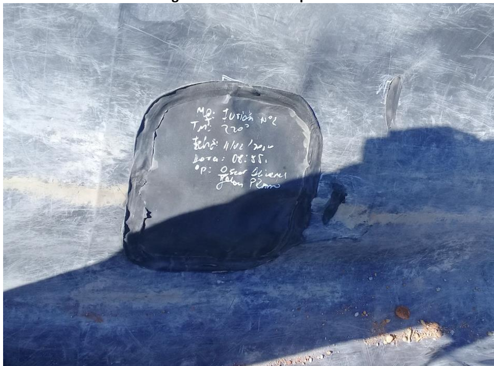
Imagen N°2: Detalles Reparación
