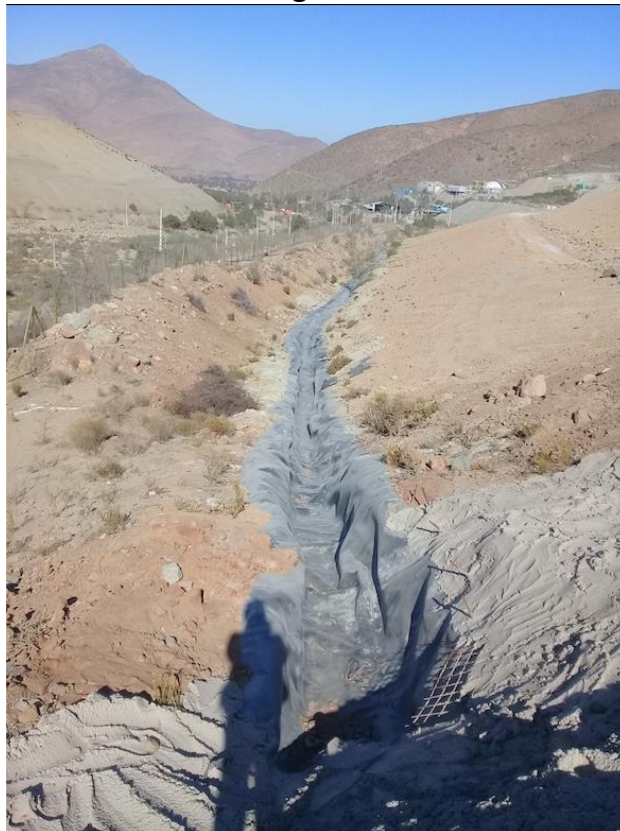
Imagen N°1: Canal de Contorno Piscina Aguas Contacto con membrana instalada
